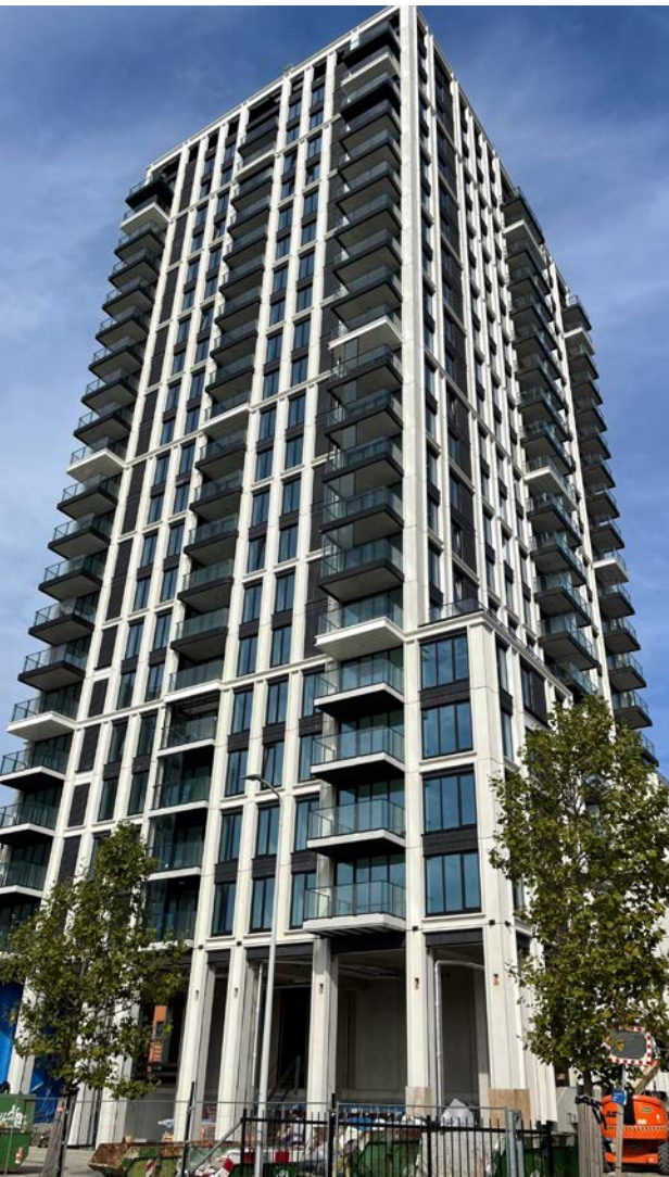
In totaal zijn zo’n 37 elementen per gevel gemonteerd, in een tempo van slechts zeven dagen per verdieping.
