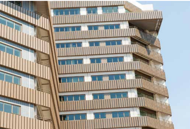
Door het borstweringsdeel tot aan de vloer te slopen, ontstond ruimte voor verdiepingshoge kozijnen met draaiende delen naar de nieuwe balkons.
