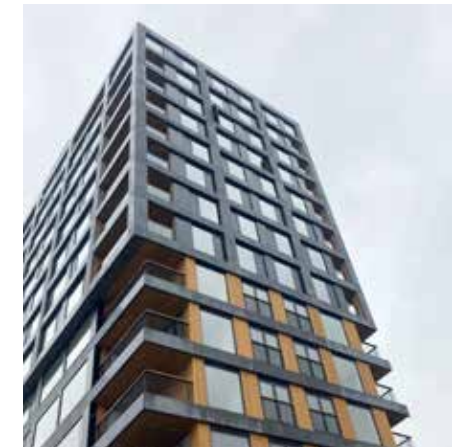
Het Havenkwartier is een mooi visitekaartje voor Facédo, vanwege de omvang, diversiteit én manier waarop de gevels gemonteerd worden.
