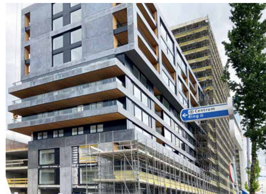
Facédo heeft circa 1.600 (totaal: 7.512 m 2 ) aluminium kozijnen en schuifpuien voor het Havenkwartier geleverd, gemonteerd en luchtdicht afgewerkt.
