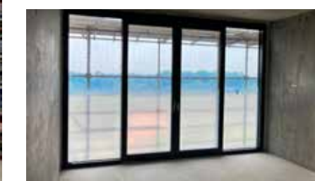
In dit werk zit 4.500 m 2 vliesgevel en circa 400 stuks aan kozijnen, die vooral bestaan uit schuifdeuren vanwege de vele balkons en Franse balkons.
