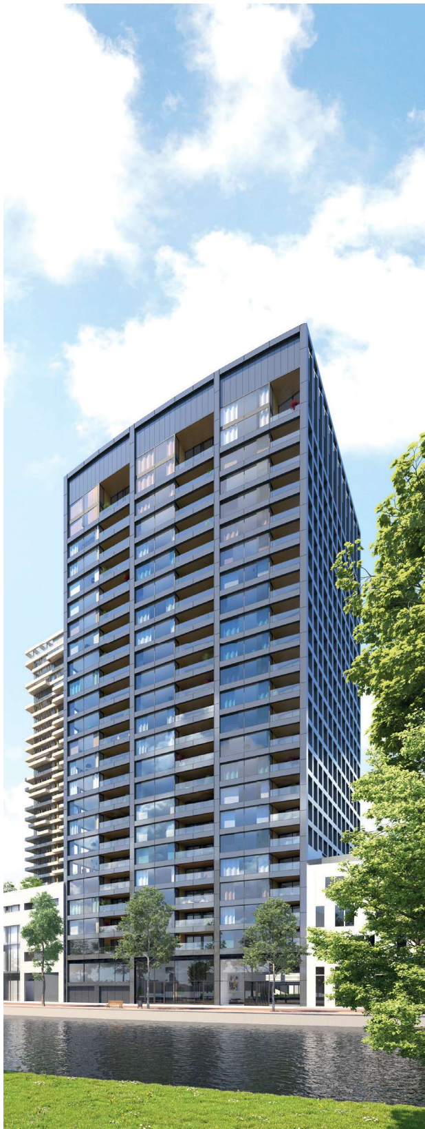
Met ongeveer 14.000 m 2 gevelelementen en 4.000 vierkante meter PV-panelen is de gebouwschil van BOLD een bijzondere verschijning.
