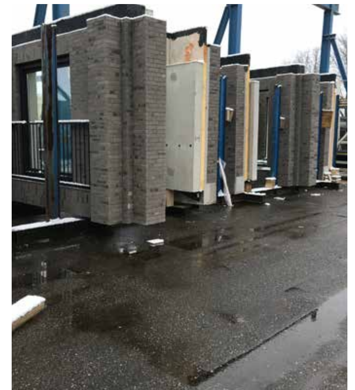
Op het tasveld bij de betonfabriek worden de kozijnen en Franse balkons voorge-monteerd.
