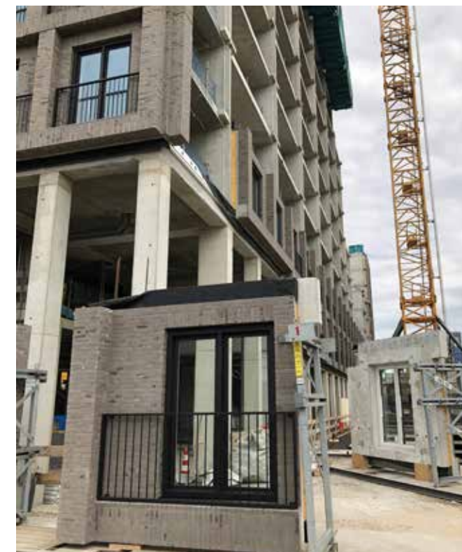
Een element staat kant-en-klaar gereed om gestapeld te worden.
